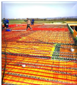
Verlegung der BTA Heizung/Kühlung
