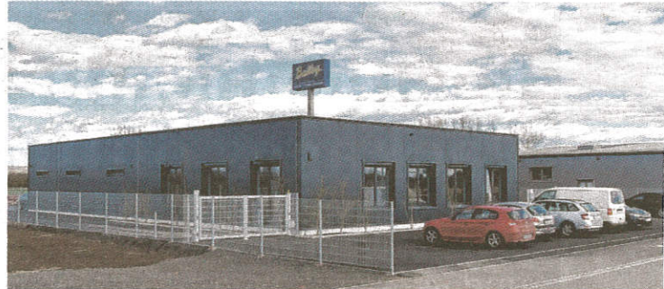
Das neue Gebäude der Firma Balley im Gewerbepark in Grafenwörth ist seiner Zeit voraus und setzt neue Maßstäbe.
